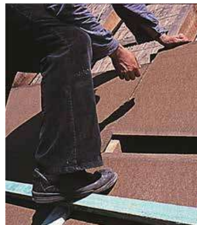
Afb. 8 Plaatsing van de platen.
