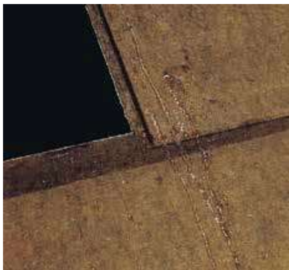
Afb. 2 De kopse tand van Celit 4D watert af bovenop de langse tand, waardoor aflopend water onder aan de kopse voeg opnieuw naar het oppervlak van de onderliggende plaat wordt afgevoerd.
