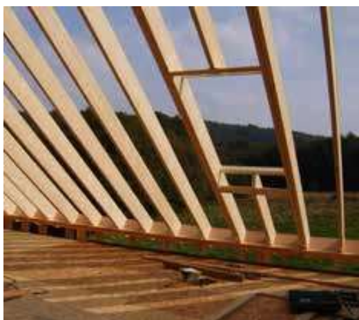
Afb. 18 Gebruik van een mal voor de maatvoering van de raveelconstructie voor een dakraam.
