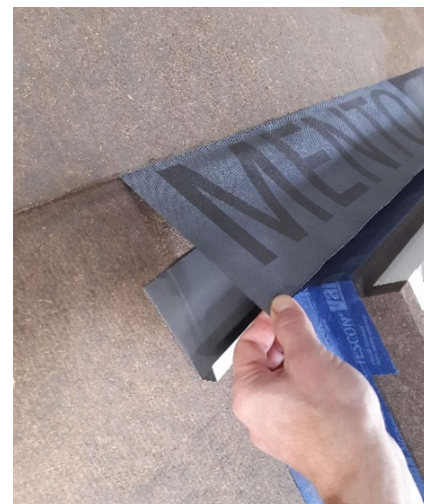
Afb. 13 Voorbeeld van een detail boven een dakraam
