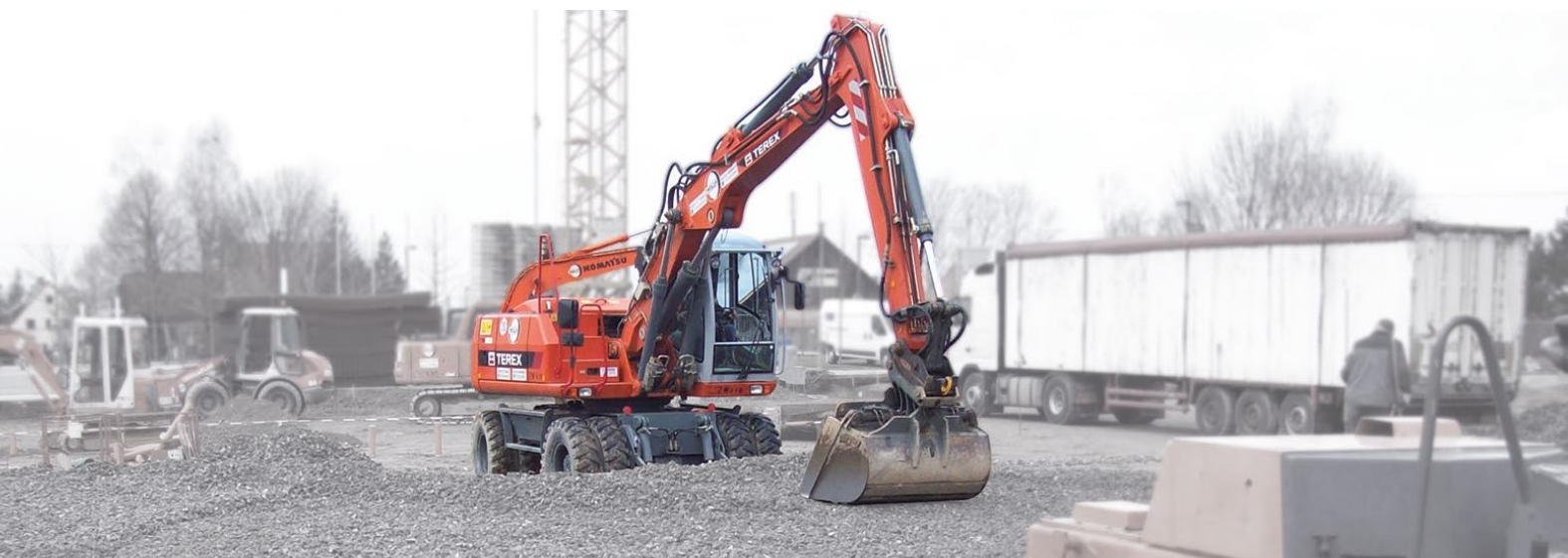
Grootschalige installatie van veriso glasschuimgranulaat voor een productiehal
