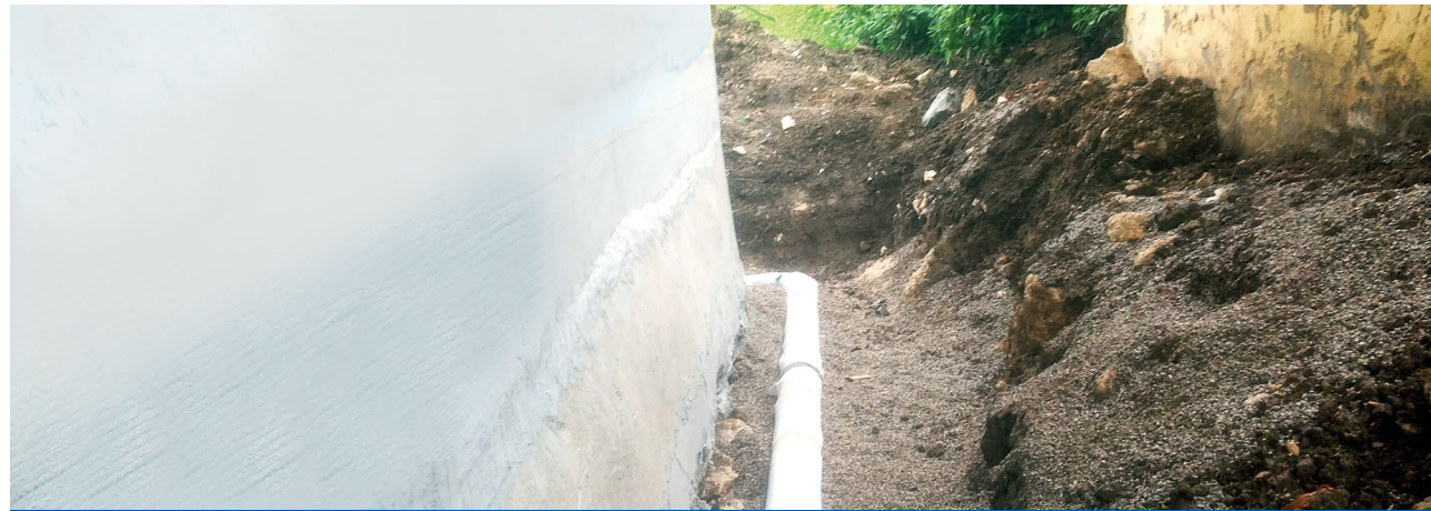
Blotleggen van het metselwerk, afdichting volgens DIN, maken van een afvoersysteem
