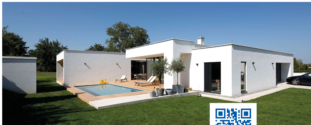
© Foto: Kikovič in Siegenhof/Burgenland © Wolfgang Paschinger, PASCHINGER ARCHITECTEN ZT, Wien
